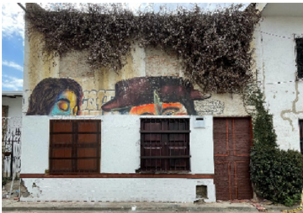
Figura 12: Resultado de la intervención en la fachada, “Casa de las Animas”.
